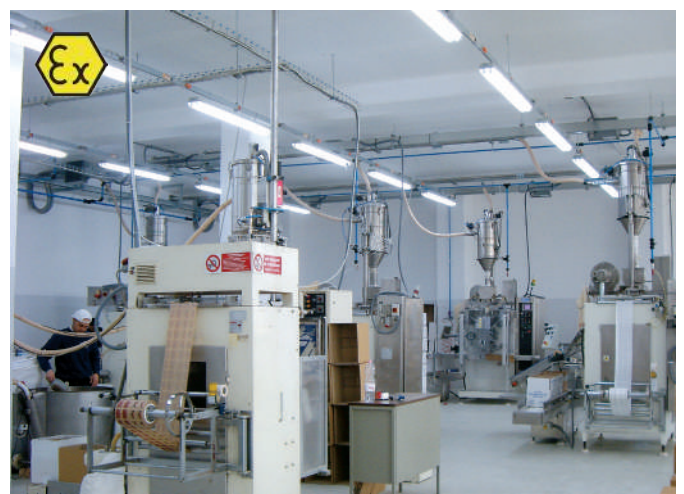
Sistema di trasporto pneumatico su un totale di 9 macchine confezionatrici con prelievo da 4 big-bags in un'industria di confezionamento dello zucchero. Sistema realizzato in versione ATEX per zona 22.
