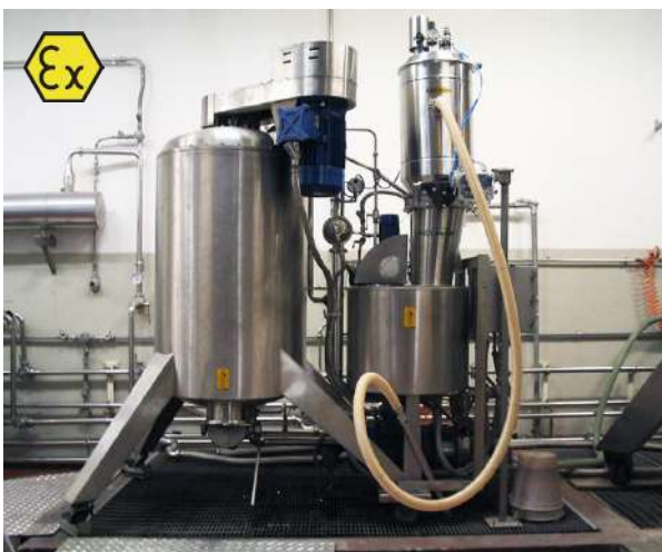
Sistema di trasporto di perlite, ad aria compressa per zona ATEX 1-2 su un'unità filtrante in una distilleria.
