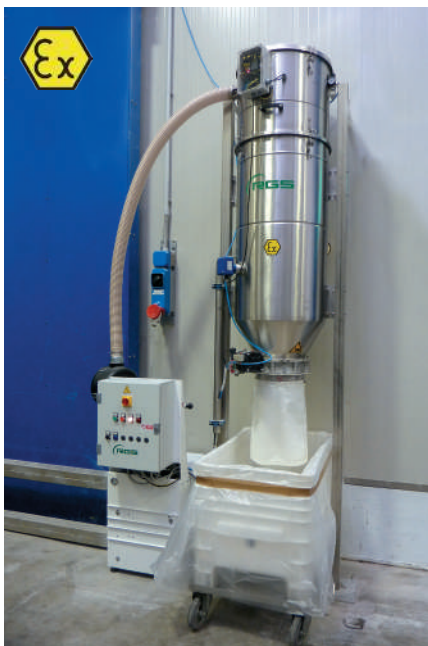
Sistema di trasporto pneumatico per farine e residui di lavorazione in una pizzeria industriale. Sistema realizzato in versione ATEX per zona 22 polveri.
