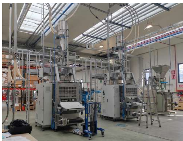
System załadunku do pionowych maszyn do pakowania kawy rozpuszczalnej.
