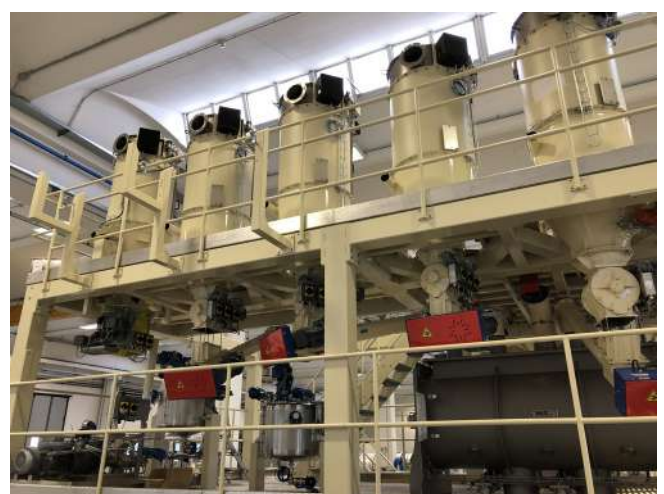
Pneumatyczny system transportu proszków tytoniowych, przechowywanie w silosach i dozowania na mieszalniku.
