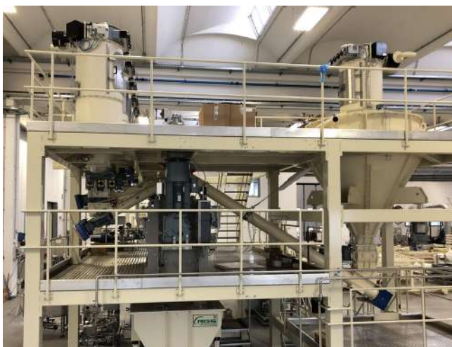
Pneumatyczny system transportu proszków tytoniowych, przechowywanie w silosach i dozowania na mieszalniku.
