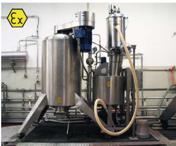
Transport pneumatyczny perlitu z transferem do jednostki filtracyjnej w destylarni, zasilany sprężonym powietrzem. W wersji ATEX dla strefy 1-2.
