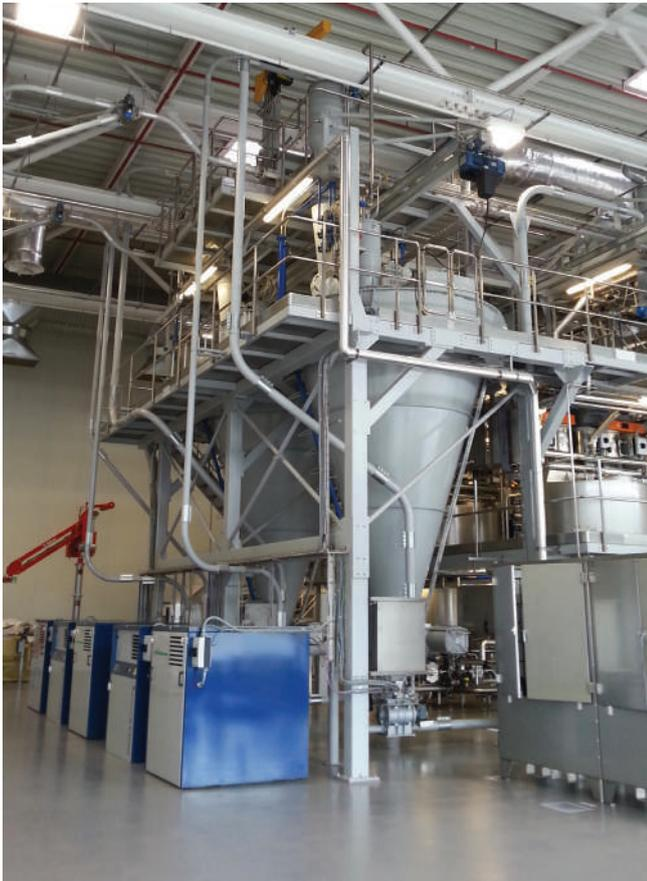
Compresores de presión para el transporte de polvo de tabaco.
