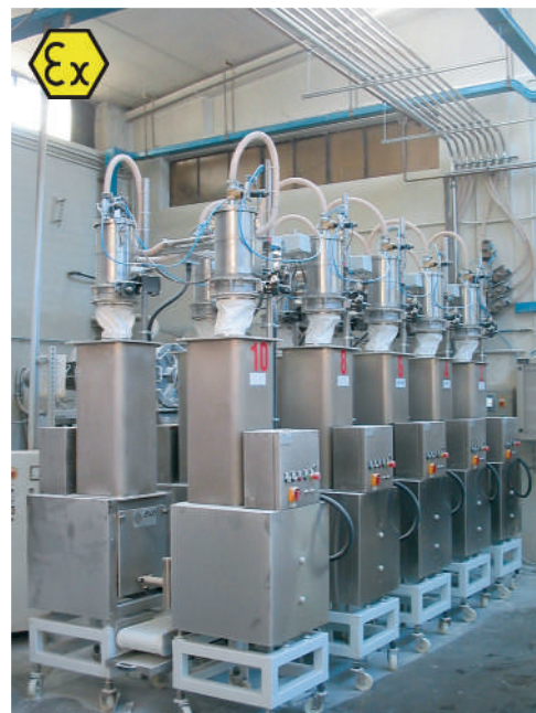
Impianto di trasporto e dosaggio con gestione di ricette (10 prodotti) in un panificio industriale. Sistema realizzato in versione ATEX per zona 22 polveri.
