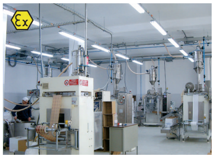
Sistema di trasporto pneumatico su un totale di 9 macchine confezionatrici con prelievo da 4 big-bags in un'industria di confezionamento dello zucchero. Sistema realizzato in versione ATEX per zona 22.
