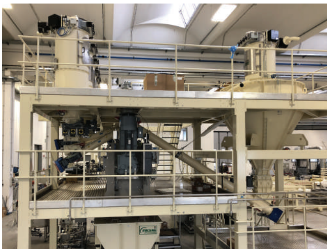
Impianto di trasporto pneumatico per polveri di tabacco, stoccaggio in silo e dosaggio su miscelatore.
