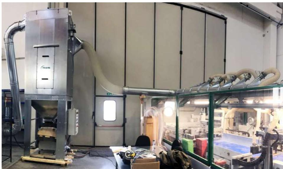
A aspiração localizada tem a função de capturar os poluentes o mais próximo possível do ponto de geração de pós (fonte) e reduzi-los antes do lançamento na atmosfera reduzindo as concentrações a valores compatíveis com a proteção ambiental.
